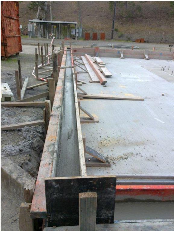
Figure 15 Pour of bund walls
