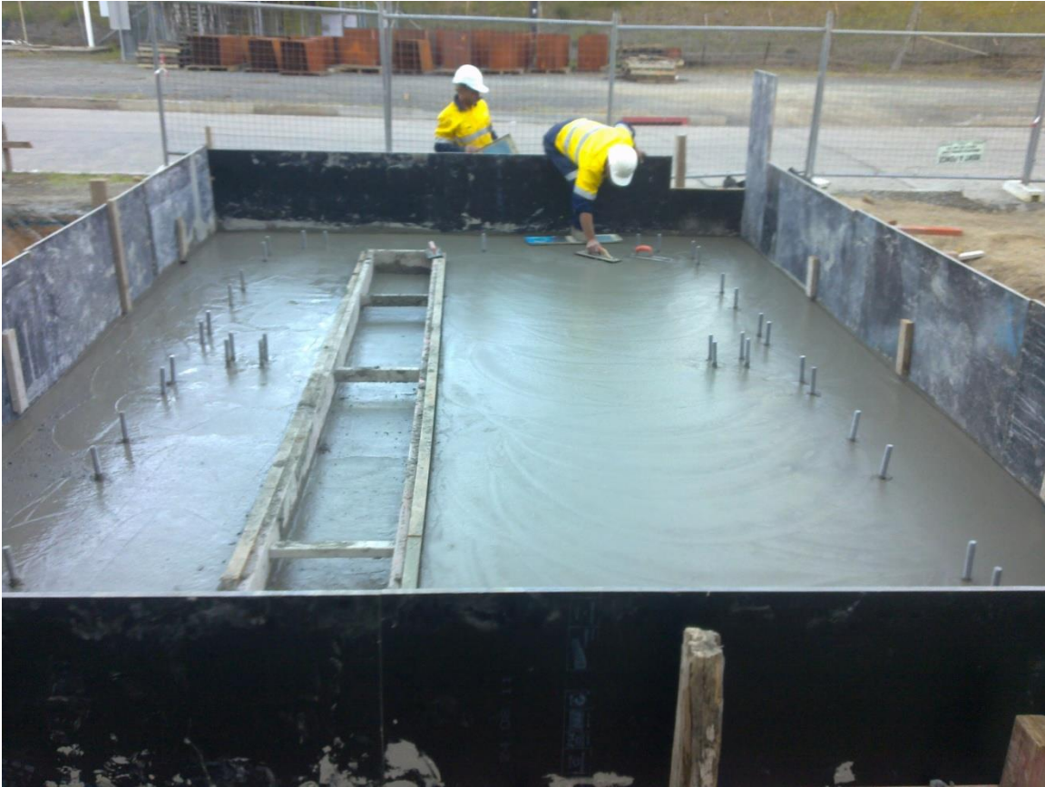
Figure 10 Structure slab pour and finish
